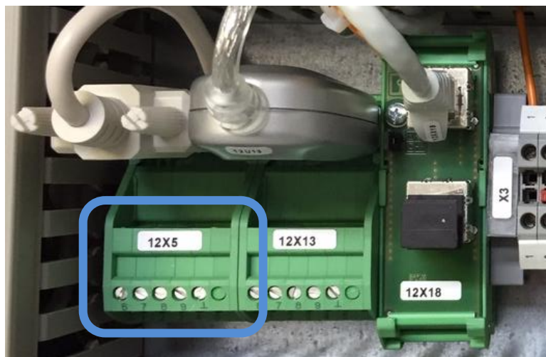
Figuur 10: Klemaansluitingen CQ-Net UMI t.b.v. seriële kabel van de brandmeldcentrale
