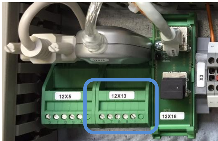
Figuur 21: Klemaansluitingen CQ-Net UMI t.b.v. seriële kabel naar het externe systeem
